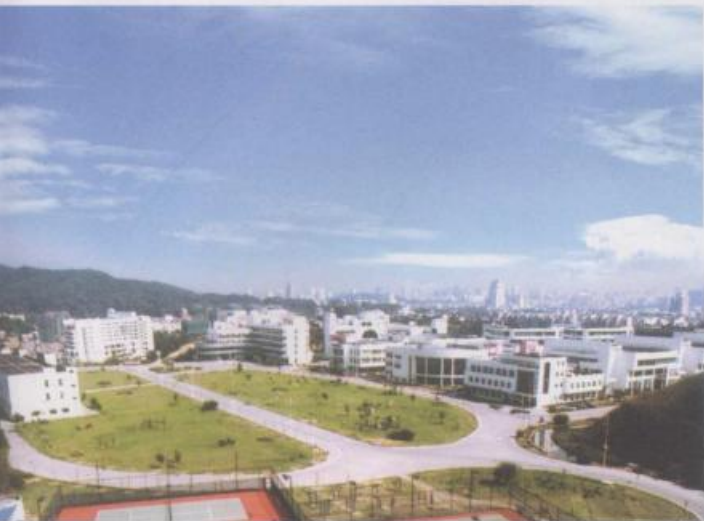
一期全景（俯视）
